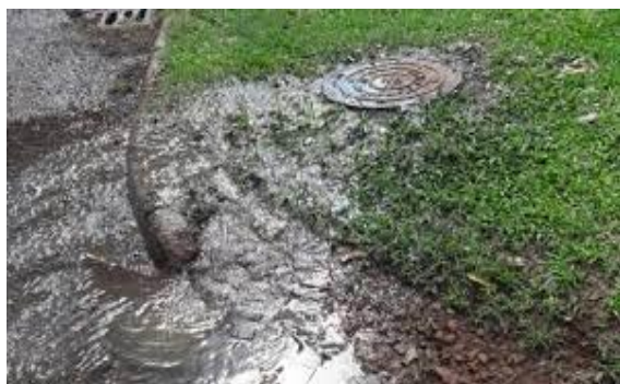
Figura 04 – Esgoto extravasando
